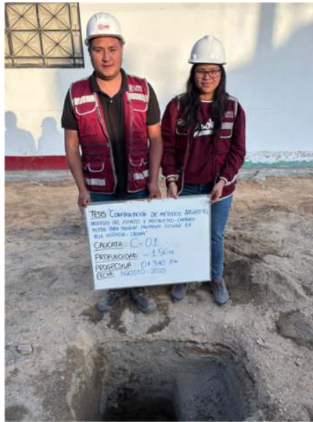
FOTOGRAFIA N°08: Excavación de la calicata (C-01), progresiva 0+340 KM
