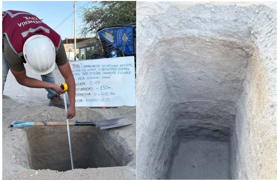
FOTOGRAFIA N°13;14: Profundidad de la calicata (C-03) 1.50m, así como el perfil estratigráfico del suelo.
