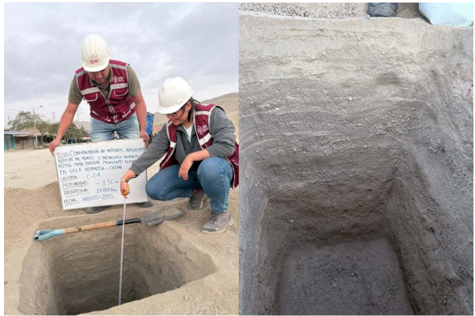
FOTOGRAFIA N°16;17: Profundidad de la calicata (C-04) 1.50m, así como el perfil estratigráfico del suelo.
