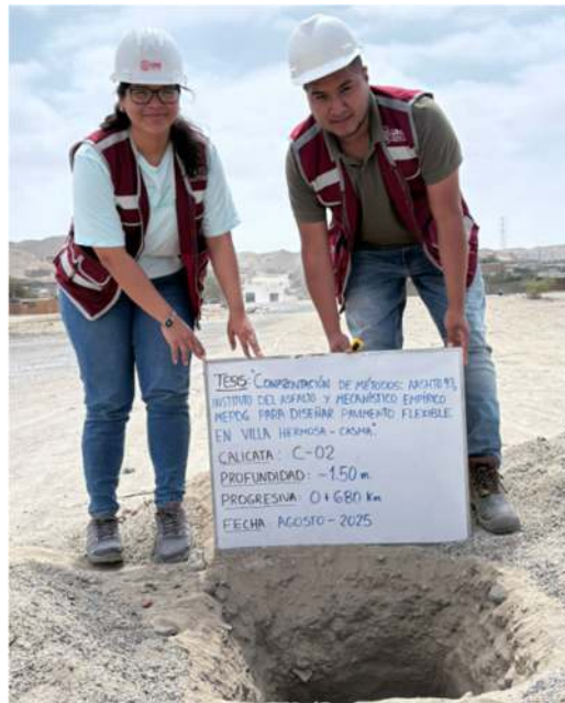
FOTOGRAFIA N°09: Excavación de la calicata (C-02), progresiva 0+680 KM
