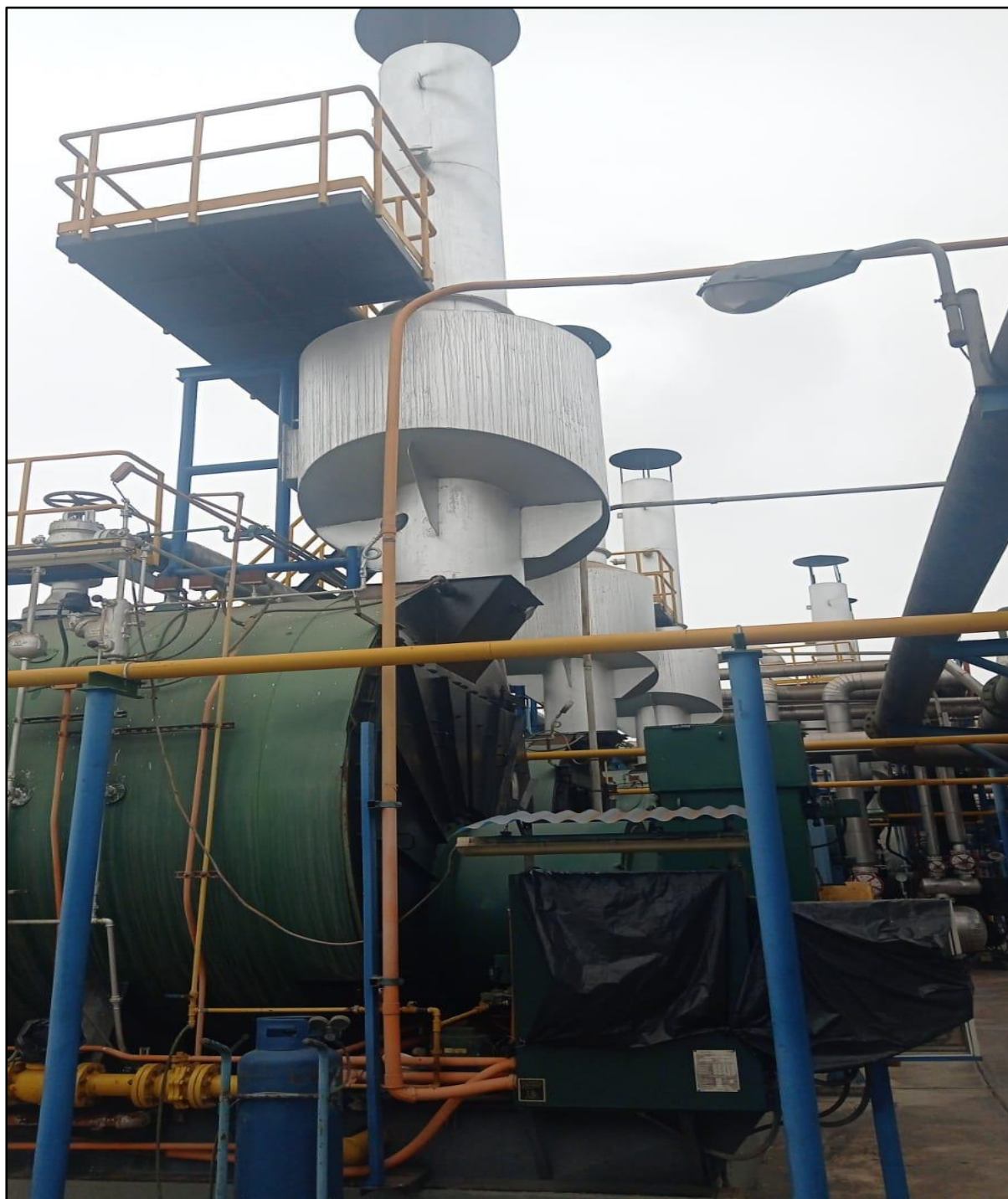
Anexo 19. Ubicación de caldera pirotubular de 1500 BHP de la planta Copeinca - Chancay
