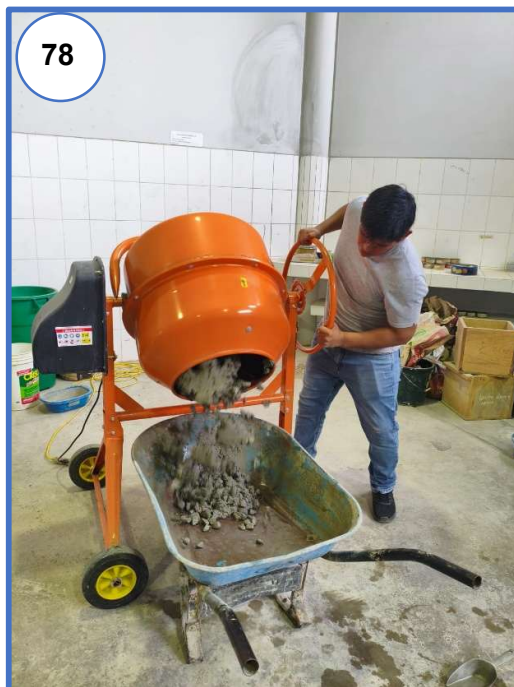
Fotografía N° 78: Luego de haberse mezclado debidamente los materiales se proceden a vaciar el concreto a una carretilla tipo buggy.
