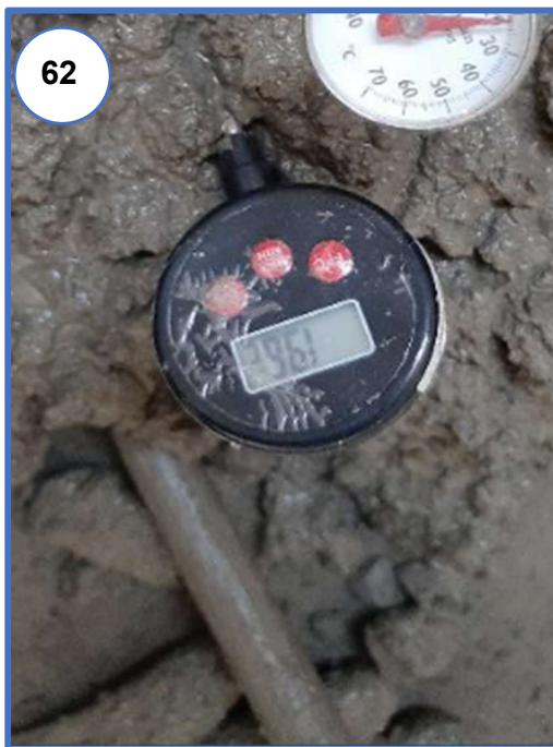
Fotografía N° 61 y N° 62: Luego de haberse mezclado debidamente los materiales se proceden a vaciar el concreto a una carretilla tipo buggy, continuamente se hace la medición de la temperatura
