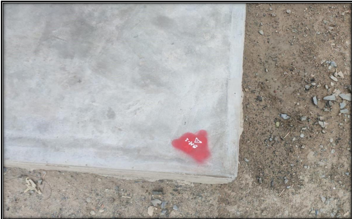
FOTOGRAFÍA 04: Colocación del BM N°01.
