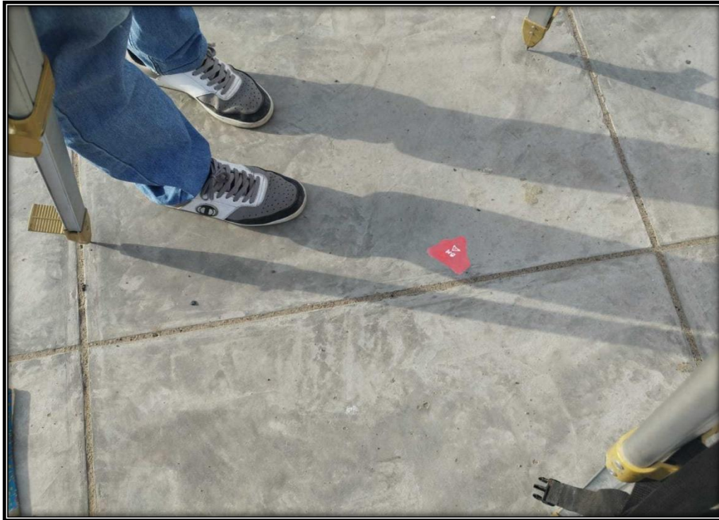
FOTOGRAFÍA 05: Colocación del BM N°02
