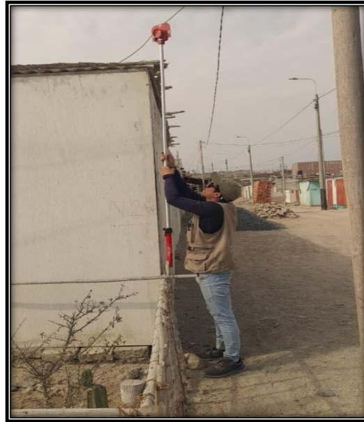
FOTOGRAFÍA 03: Se observa al ayudante prismo utilizando el prisma para poder realizar el levantamiento topográfico.
