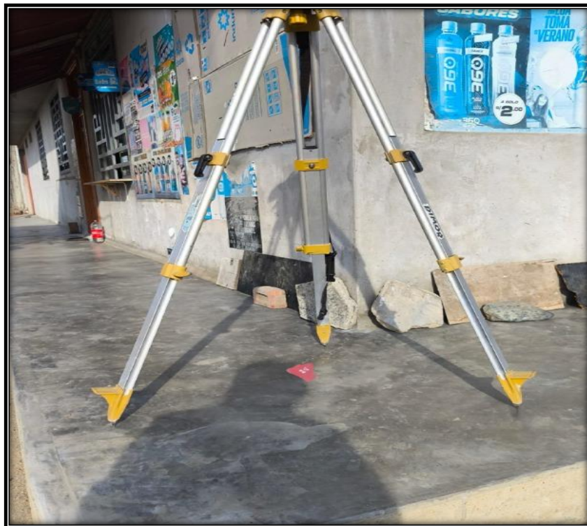
FOTOGRAFÍA 10: Colocación del BM N°07
