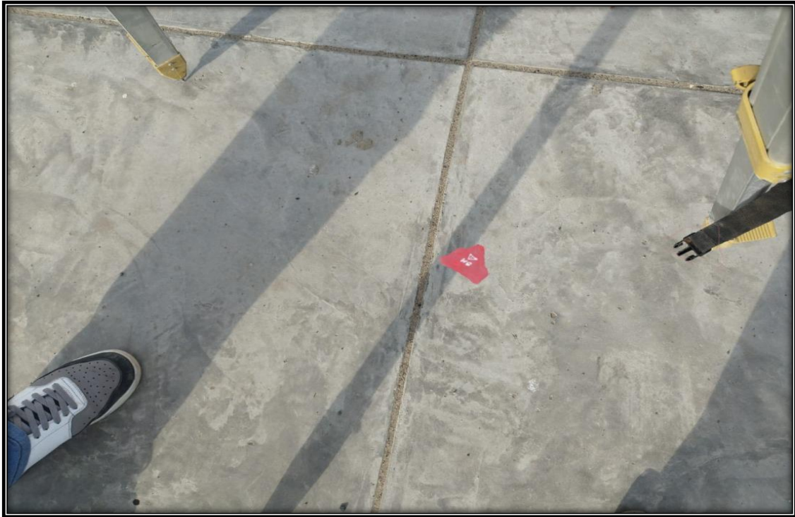
FOTOGRAFÍA 07: Colocación del BM N°04
