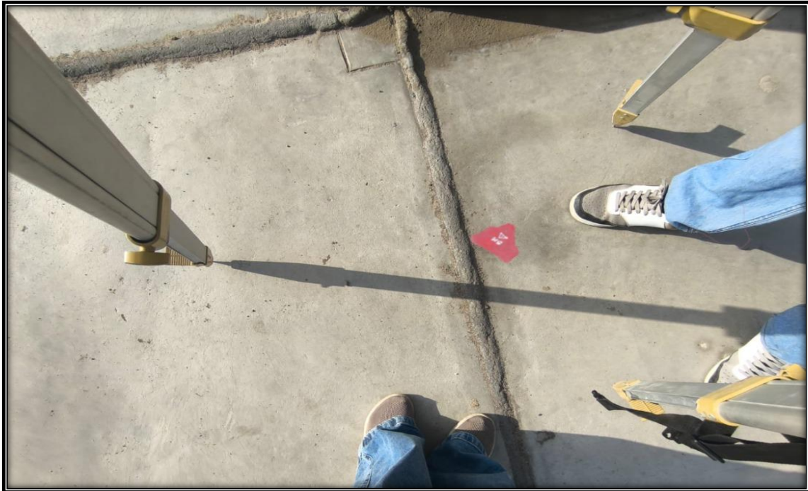
FOTOGRAFÍA 09: Colocación del BM N°06
