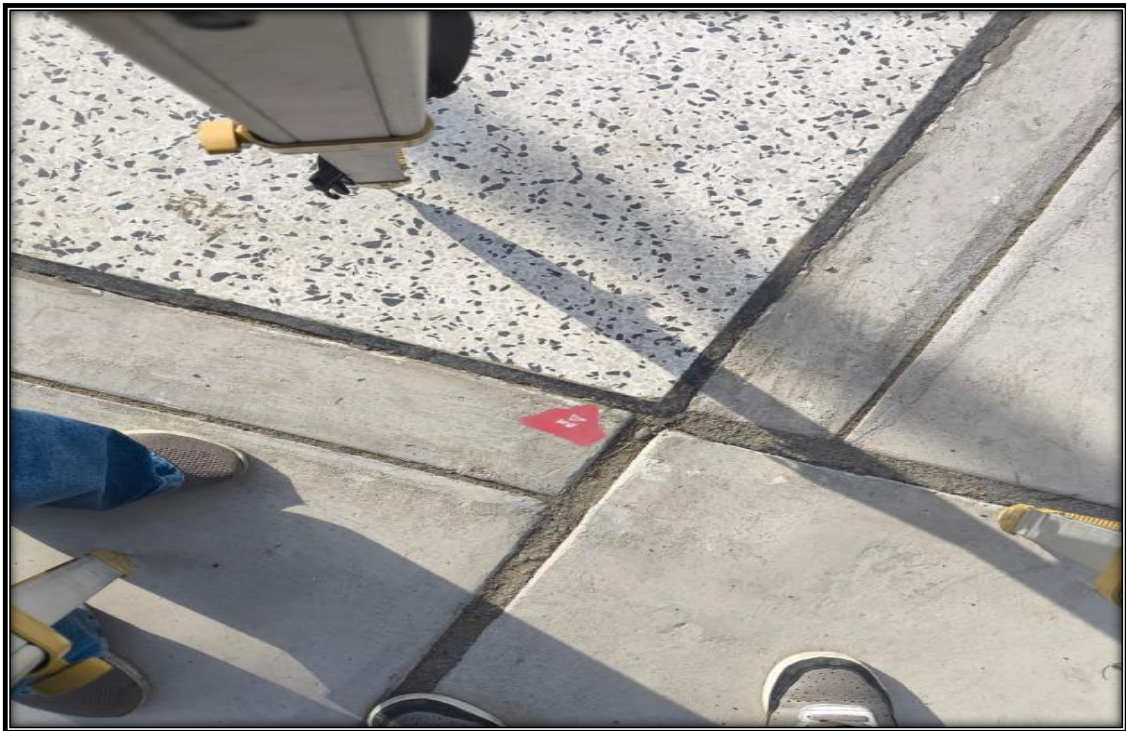
FOTOGRAFÍA 08: Colocación del BM N°05
