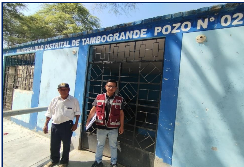
Fotografía 8. Vista de los exteriores de la caseta de bombeo
