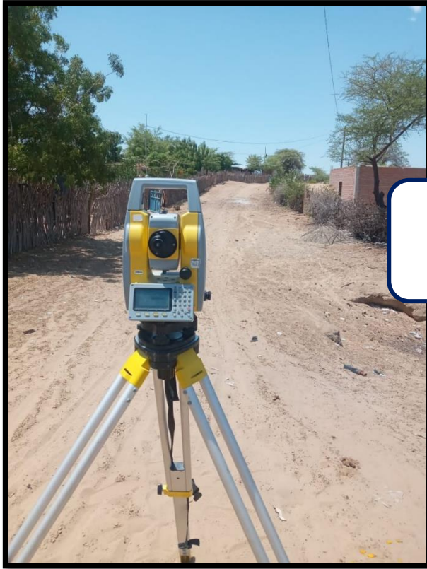
FOTO N°03: Levantamiento topográfico realizado en el Centro Poblado Los Chuicas
