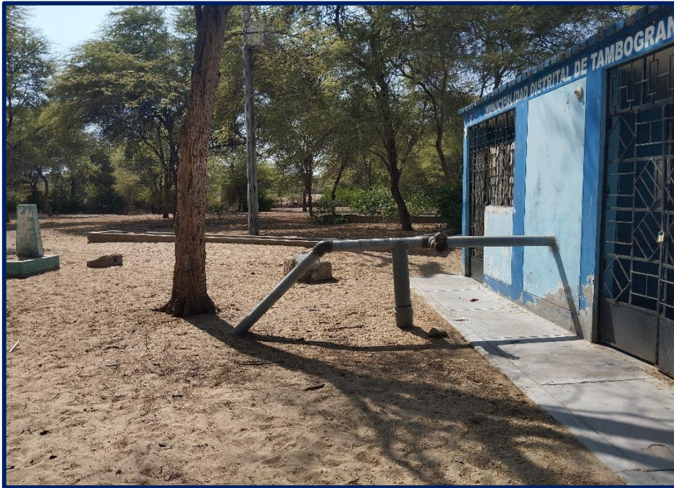
Fotografía 10. Vista de la línea de impulsión
