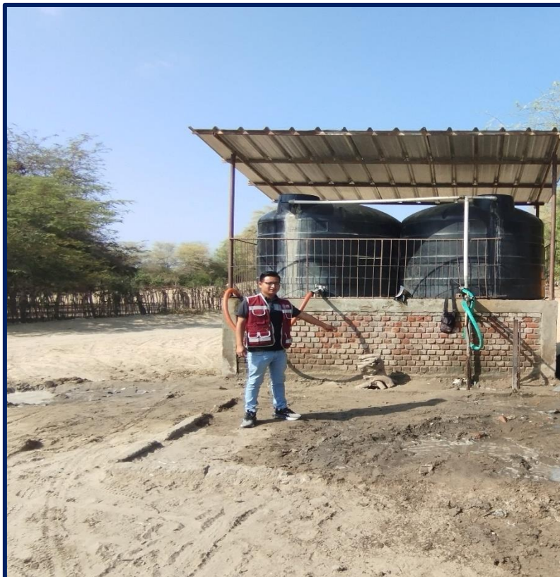
Fotografía 17 Inspección de la Pileta Pública del C.P. San Martin de Malinguitas
