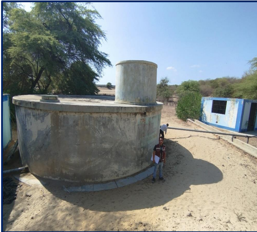
Fotografía 6. Inspección del Reservorio Apoyado
