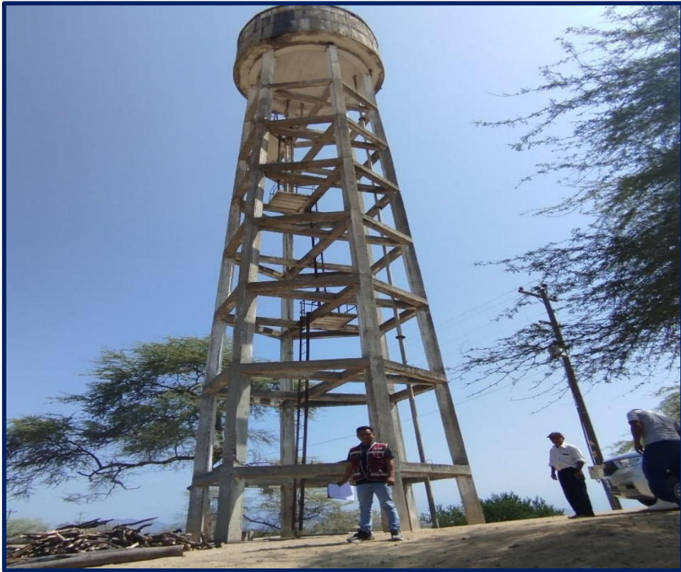
Fotografía 12 Vista del Reservorio Elevado
