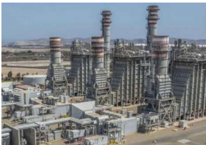
Central Termoeléctrica de Ciclo Combinada de Kallpa-Perú
